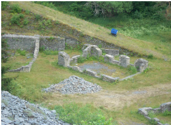
Situation zu Baubeginn Anfang Juli 2015
