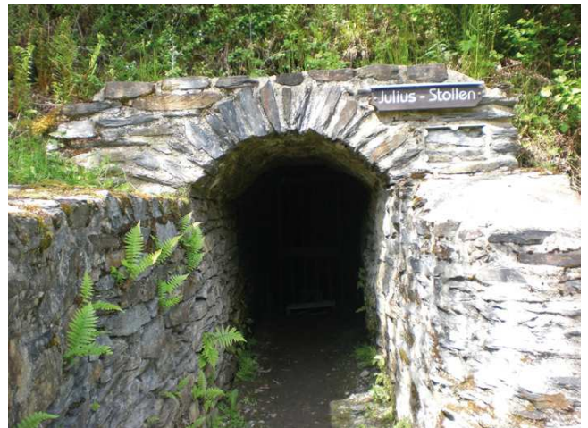
Abb. 11: Der Eingang des ebenfalls sehr alten Julius-Stollens wurde restauriert.
