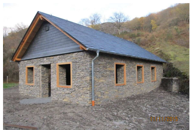
11.11.2015 (Einbau Fenster im Dezember)
