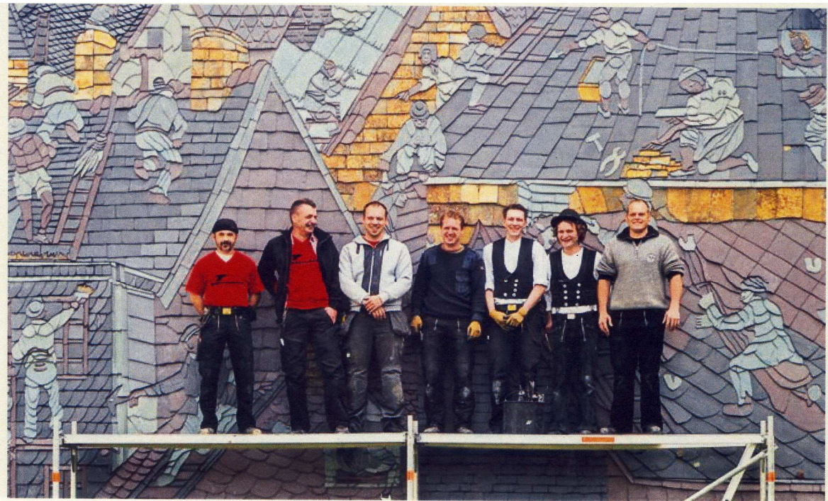
Mit einer unwahrscheinlichen „Liebe zum Detail“ setzte das 7-köpfige Team das Schieferfassadenornament um – in zweierlei Hinsicht wird dem Betrachter die traditionelle Handwerkskunst an diesem Objekt nahegebracht.
