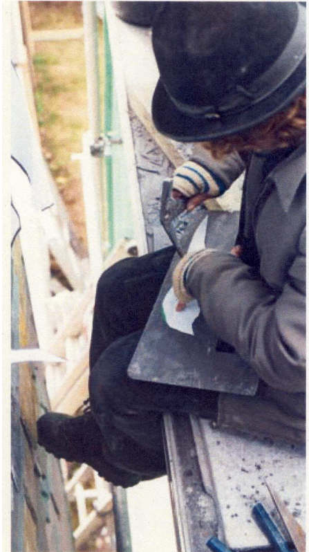
Die Dachdecker, darunter ein Wandergeselle, verarbeiteten rund 7.500 Schiefer. Für spezielle Segmente setzten die Dachdecker elektrische Schiefer-Schneidemaschinen ein.
